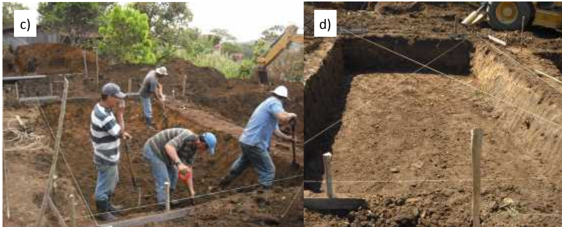
Foto 6. a) Excavación de la primera biojardinera. b) Excavación segunda biojardinera. c) Nivelación. d) Excavación nivelada. Fuente: ACEPESA.
