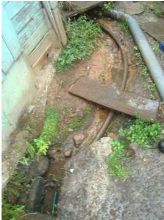
Antes: Salidas de las aguas grises de las viviendas daban al patio.
