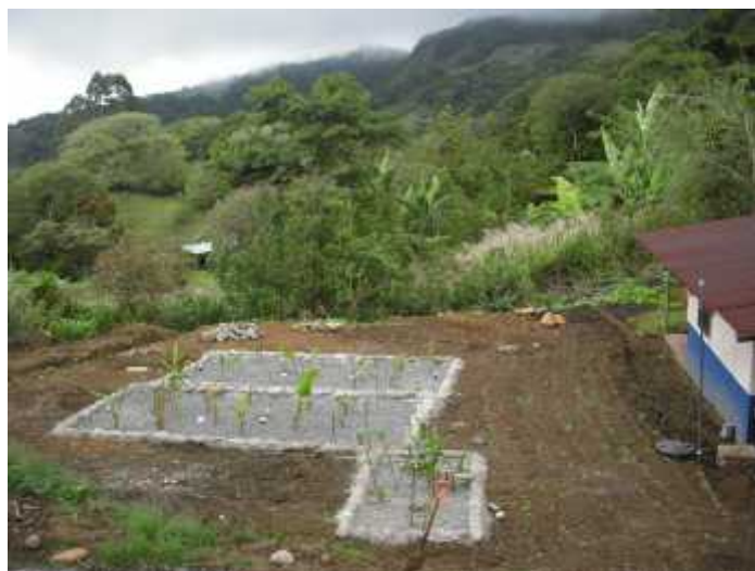
SISTEMA DE TRATAMIENTO COMUNAL
