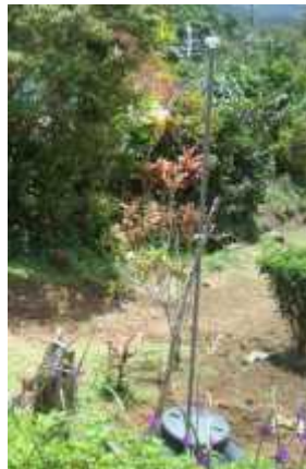
Foto 13. a) Chimenea de ventilación del tanque de pretratamiento. Fuente: ACEPESA.
