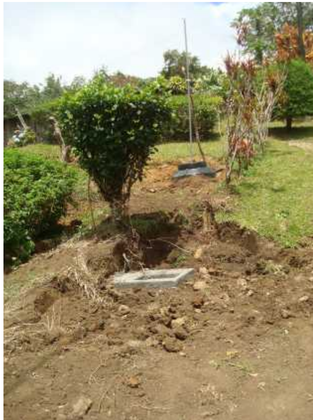
Actualmente las aguas grises se dirigen al tanque de pretratamiento donde son conducidas posteriormente a las biojardineras.
