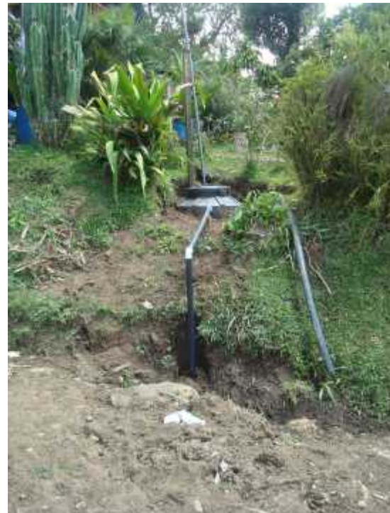
Después: Las aguas grises se dirigen al tanque de pretratamiento y posteriormente a las biojardineras.
