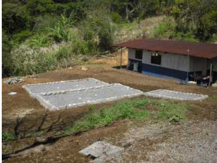
Foto 12. Canal y biojardineras terminadas, con reborde de concreto y piedra. Fuente: ACEPESA
