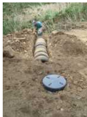
Foto 11. Tanque de almacenamiento y drenaje de llantas. Fuente: ACEPESA.
