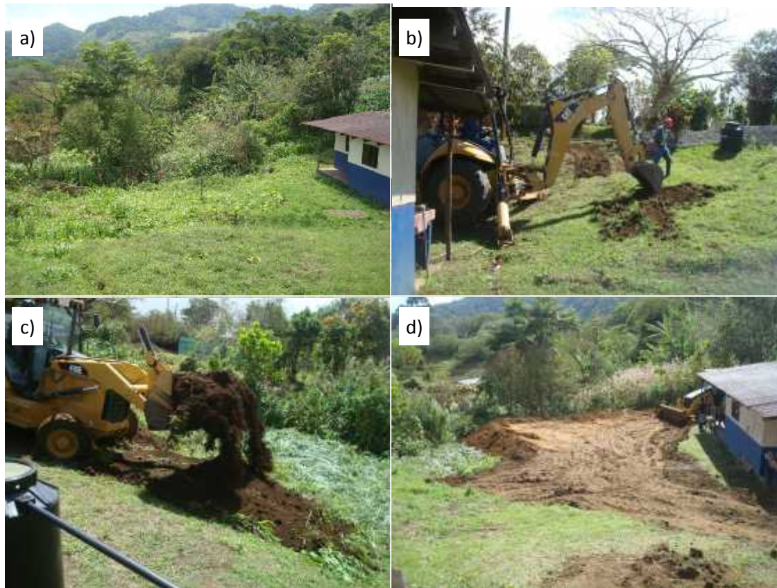
Foto 4. Nivelación del terreno: a) Terreno inicial. b) Excavación. c) Relleno. d) Terreno nivelado. Fuente: ACEPESA
