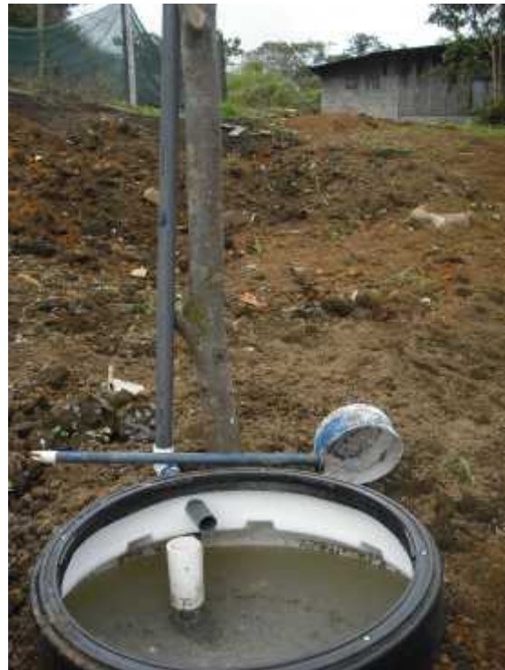
Antes: Salidas de las aguas se dirigen al tanque de pretratamiento y posteriormente a las biojardineras.
