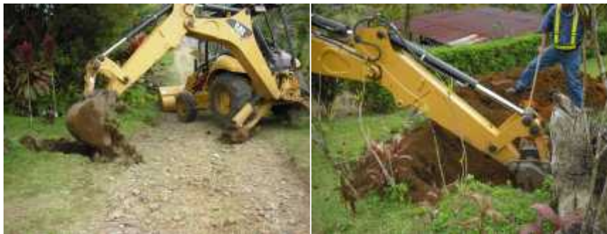
Foto 7. Excavación para tanques de pretratamiento y para tuberías. Fuente: ACEPESA.
