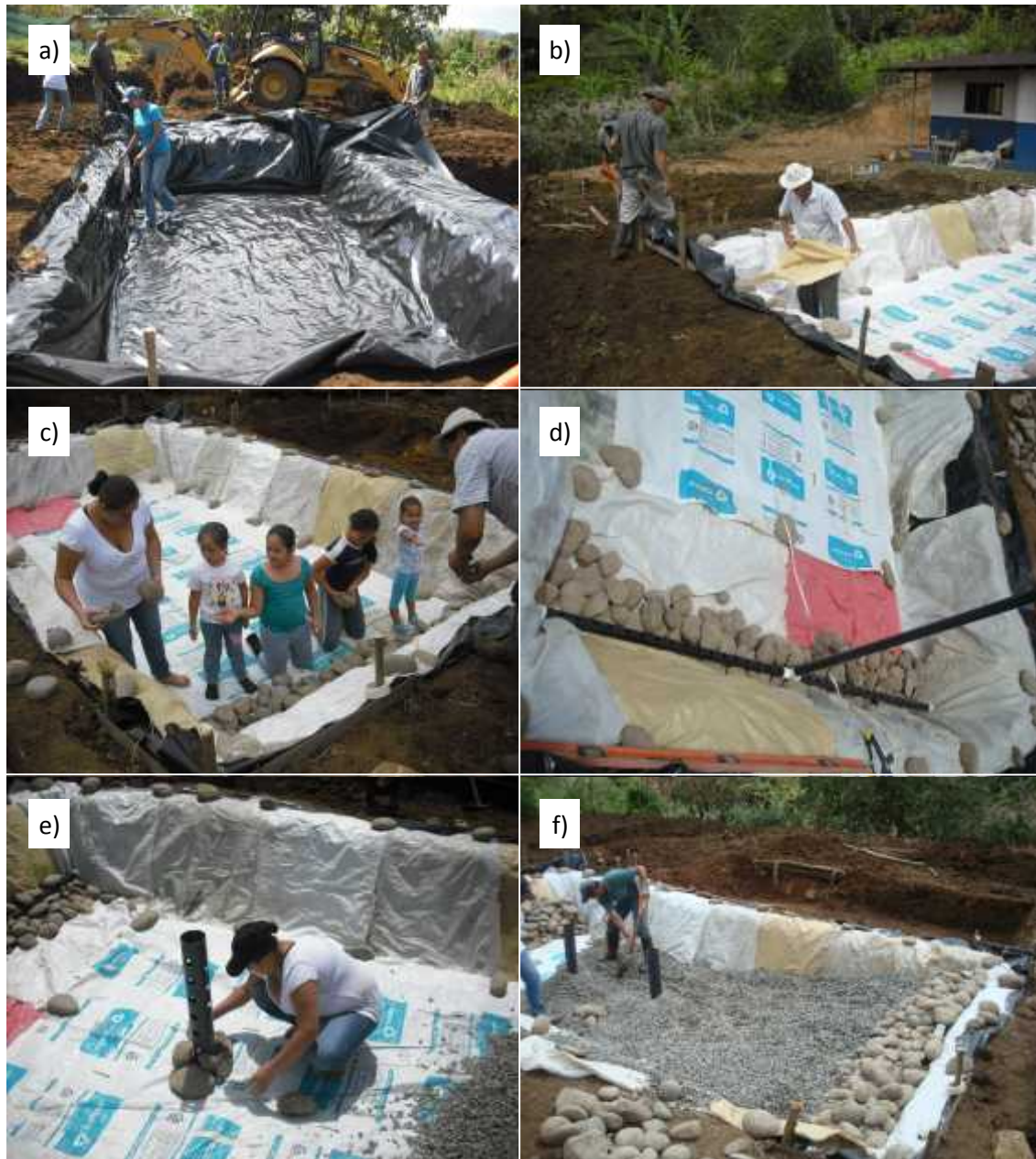
Foto 8. a) Impermeabilización con plástico. b) Sacos para proteger el plástico. c) Colocación de piedra bola. d) Tubería interna de la biojardineras. e) Respiradero de la biojardinera. f) Colocación piedra cuarta. Fuente: ACEPESA.
