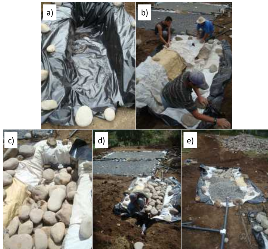
Foto 10. a) Impermeabilización del canal con plástico. b) Sacos para proteger el plástico. c) Colocación de piedra bola y tubería interna del canal. e) Piedra bola. f) Capa de Piedra cuarta. Fuente: ACEPESA.
