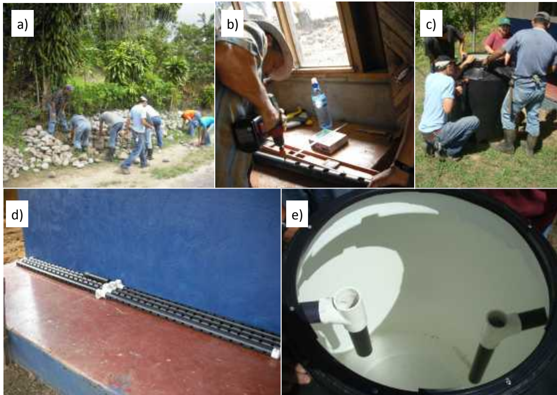
Foto 5. a) Selección de piedra. b) Preparación de tuberías internas de las biojardineras. c) Preparación de tanques. d) Tubería interna biojardineras. e) Tubería interna tanques de pretratamiento. Fuente: ACEPESA.
