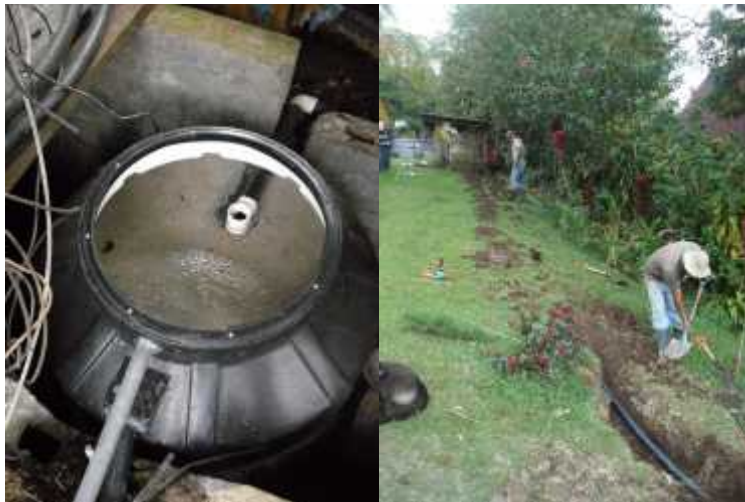
Las aguas grises se dirigen al tanque de pretratamiento y posteriormente las biojardineras. El tanque de pretratamiento fue colocado en el lugar donde estaba el antiguo biodigestor.
