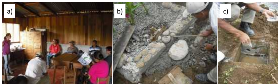
Foto 15. a) Capacitación. b, c) Arreglos de fugas en la salida de tuberías. Fuente: ACEPESA.
