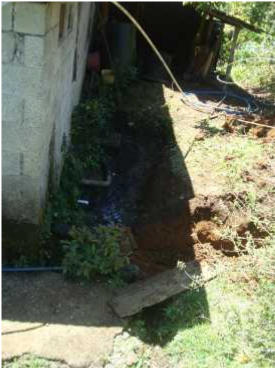
Antes: Salidas de las aguas de las viviendas se dirigían al patio.
