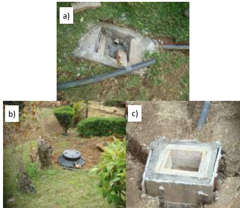
Foto 9. a) Trampas de grasas. b) Tanques de pretratamiento. c) Cajas de registro en la tubería principal. Fuente: ACEPESA.
